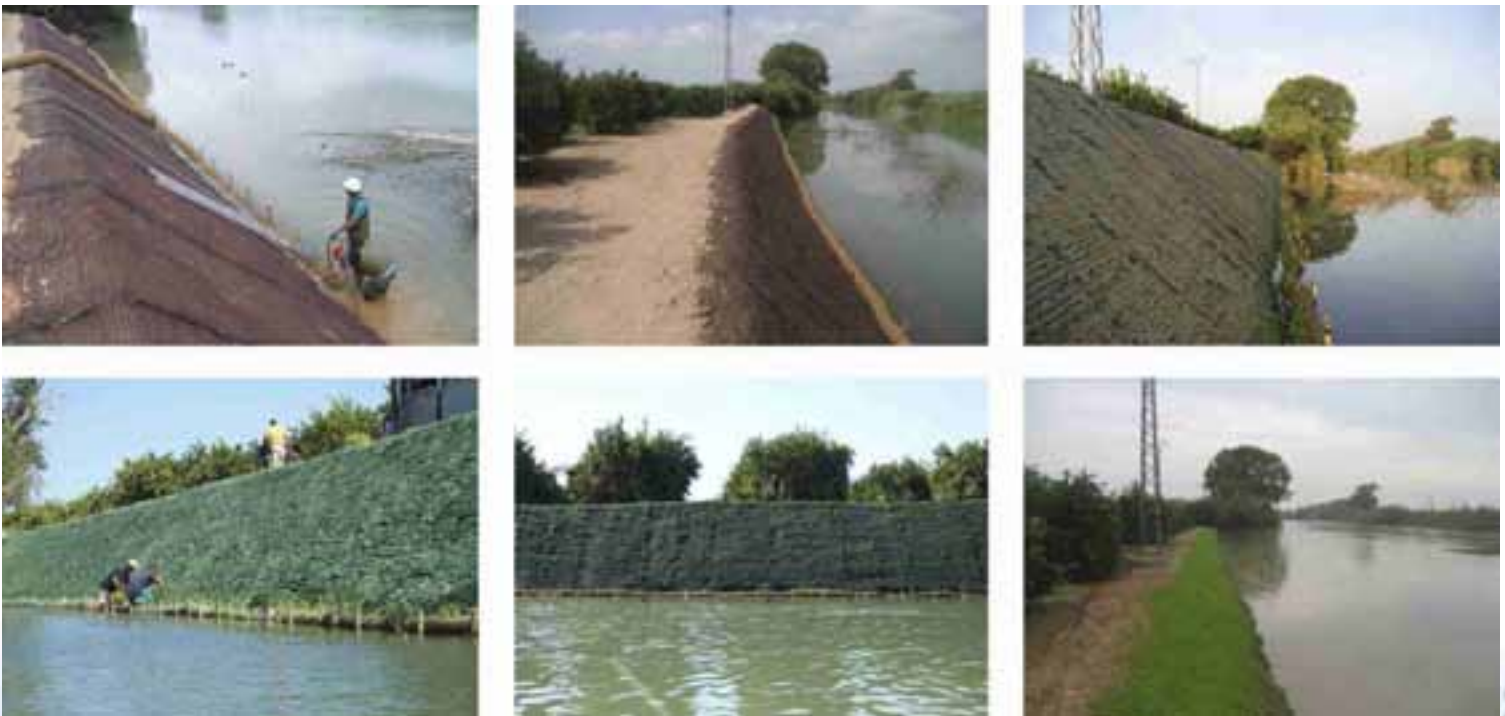
Instalación de TRINTER + HIDROMANTA + PRO-ROLL - Riola
