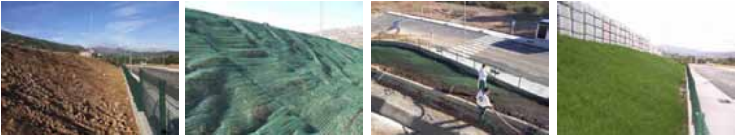
Instalación de TRINTER - Alcover
